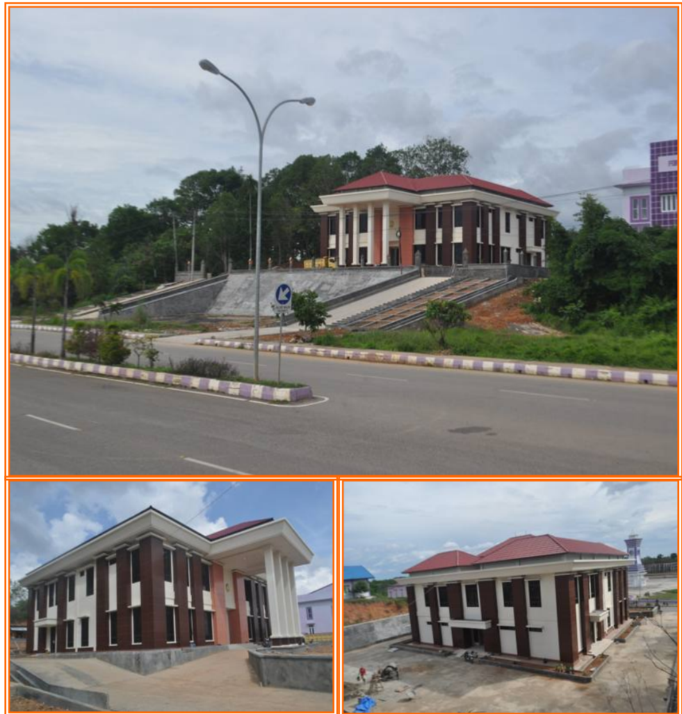
Gambar 4. Hasil Pekerjaan Sarana dan Prasarana Lingkungan Gedung Kantor Pengadilan Agama Tanah Grogot Tahun Anggaran 2015.
