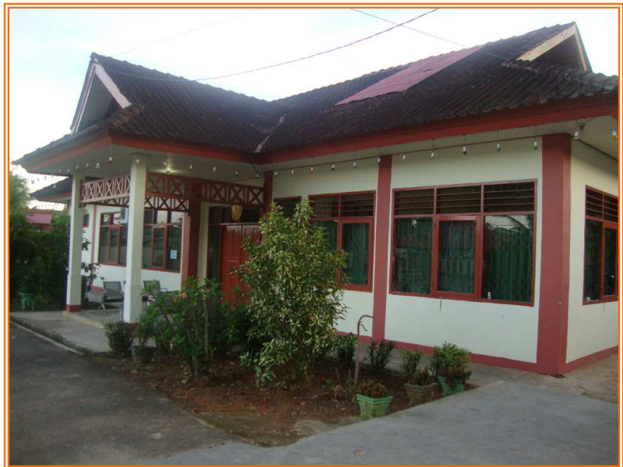
Gambar 4. Gedung Kantor Lama Pengadilan Agama Tanah Grogot.
